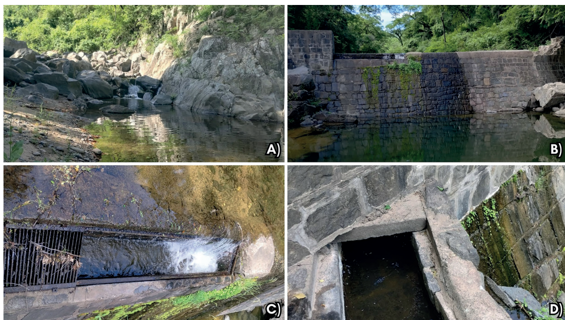
Figura 2. Sistema de riego del Diquecito (La Aguada). A) Río de La Aguada (PM2, Fig. 3B). B) Presa niveladora. C) Toma de agua con rejas. D) Canal de riego principal (PM3, Fig. 3B).
