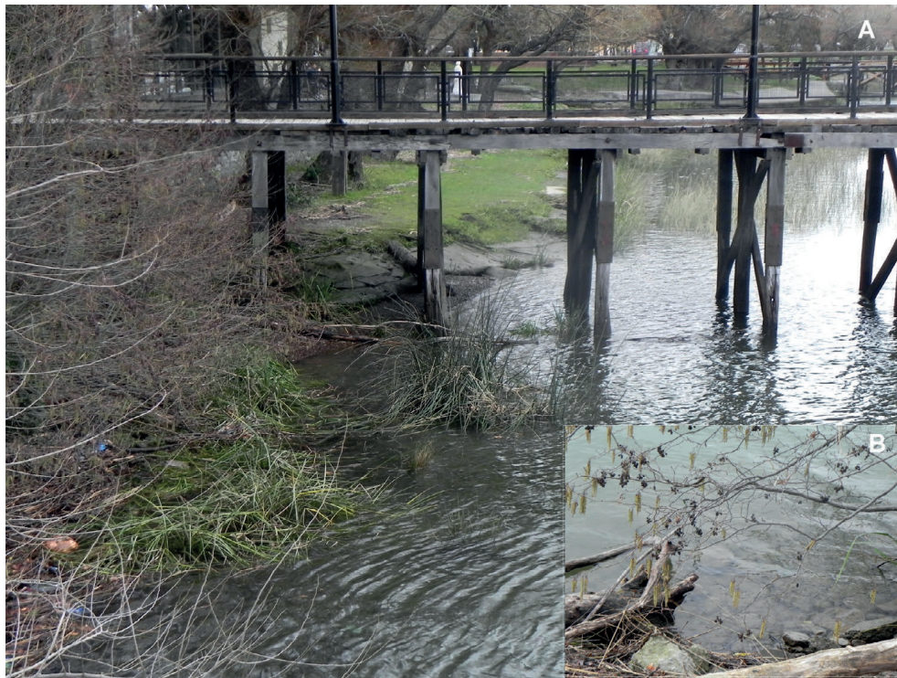
Fig. 2. Costa de Carmen de Patagones (Buenos Aires) A) Vista general de la costa donde se capturó a Tridentiger bifasciatus ; B) detalle del fondo con restos de placas de hormigón.
